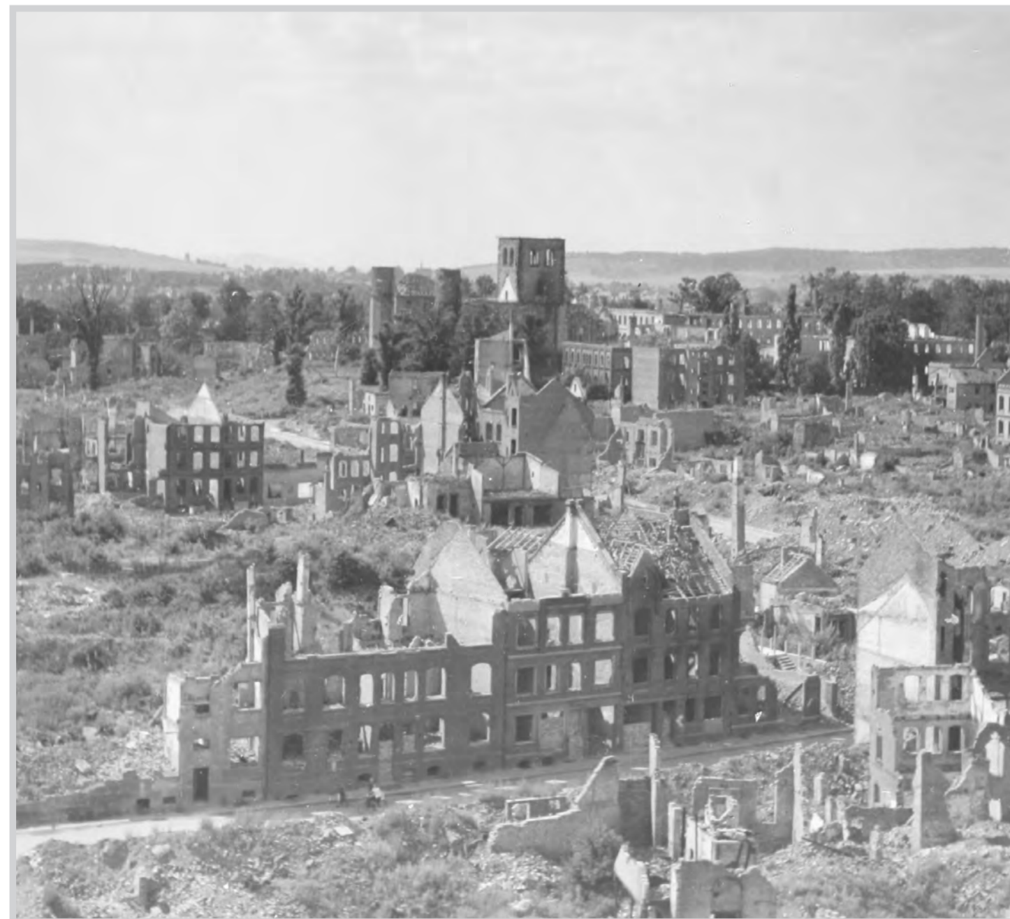
Blick auf die zerstörte Michaeliskirche nach dem 22. März 1945
