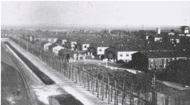
Lager V Neusustrum, Gefangenenbaracken, im Hintergrund rechts: Wachturm am Eingang des Lagers. - Quelle: DIZ
