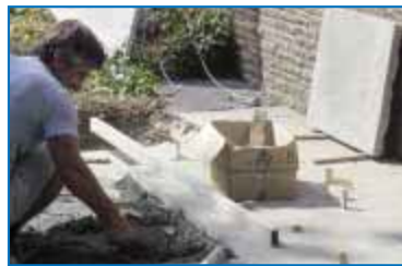
Sanierungsarbeiten in Costermano/Italien
