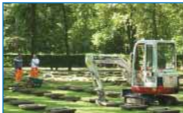
Instandsetzungsarbeiten in Vladslo/Belgien
