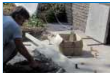
Sanierungsarbeiten in Costermano/Italien
