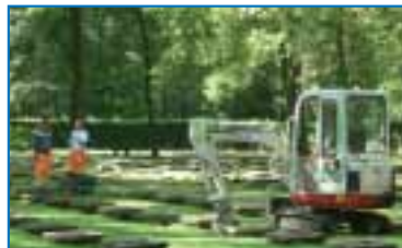
Instandsetzungsarbeiten in Vladslo/Belgien
