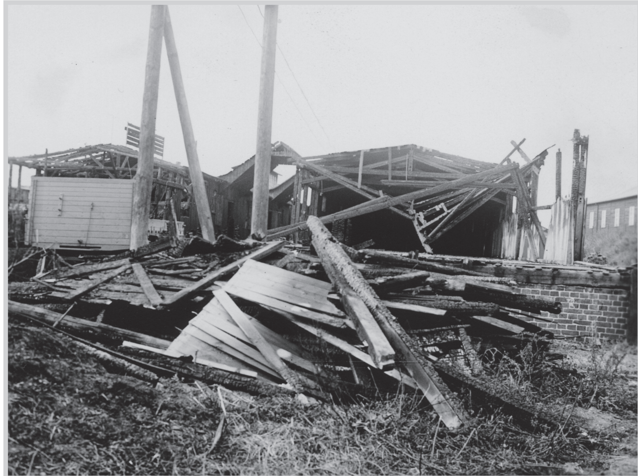
Zerstörte Schuppen am Güterbahnhof. [Quelle: Stiftung Genossenschaftliches Archiv Hanstedt]
