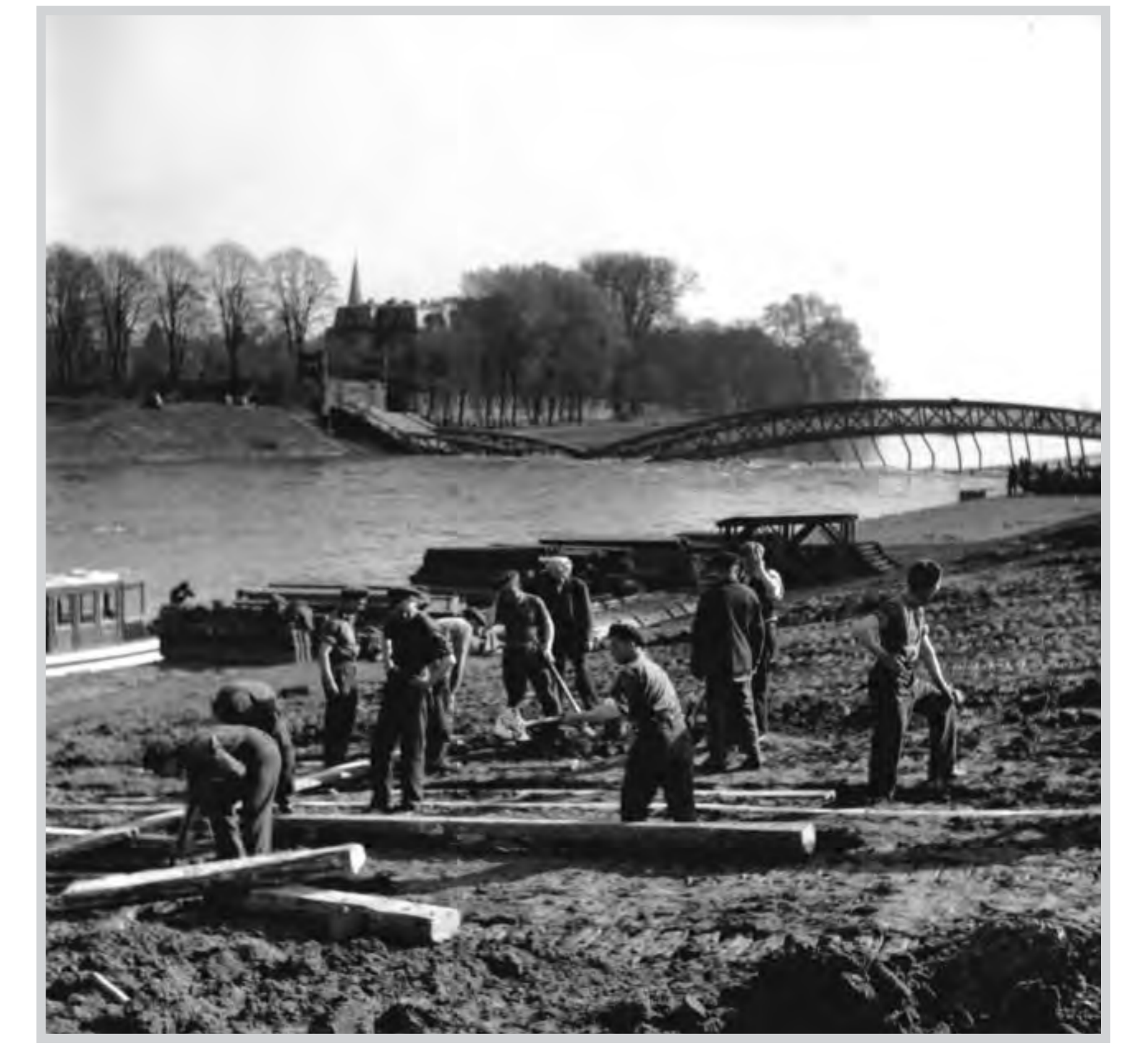
Britische Truppen errichten am 14. April 1945 eine provisorische Brücke über die Weser mit einer Tragfähigkeit von 40 t. (Quelle: Imperial War Museum, London)
