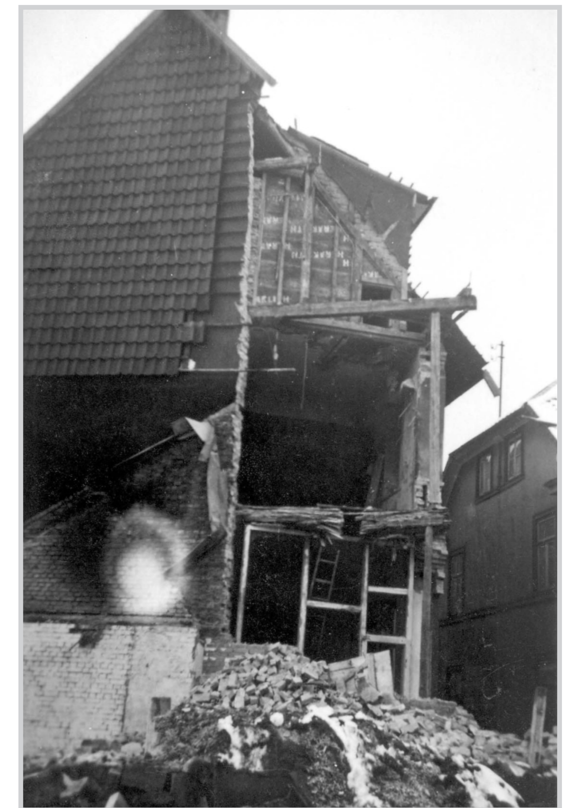
Bombentreffer im Hotel Prinz Heinrich (Quelle: Sammlung Plaster)
